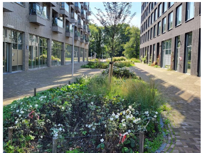
Afbeelding 195. NPD-strook: leidingwerk van WKO ligt ondergronds
